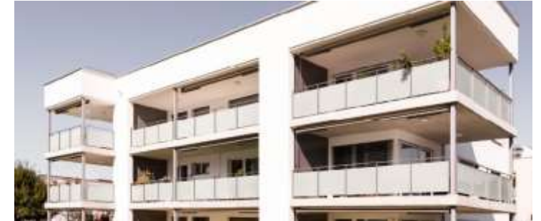
Moortalstrasse 6a+b, 5722 Gränichen Erwerb 2017, Wohnen / Alleineigentum
