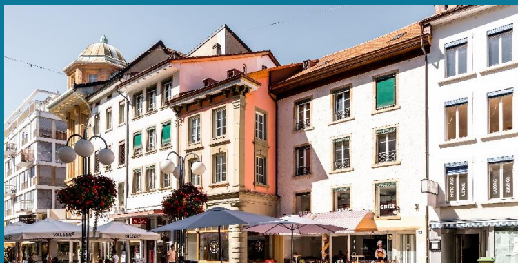
Marktgasse 5-9, 2502 Biel Kanalgasse 4-6, 2500 Biel Acquisition 2018, Mixte / Propriété exclusive
