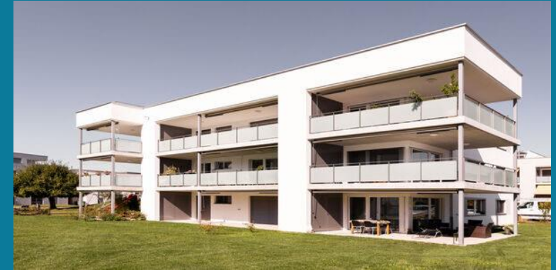
Moortalstrasse 6a+b, 5722 Gränichen Erwerb 2017, Wohnen / Alleineigentum
